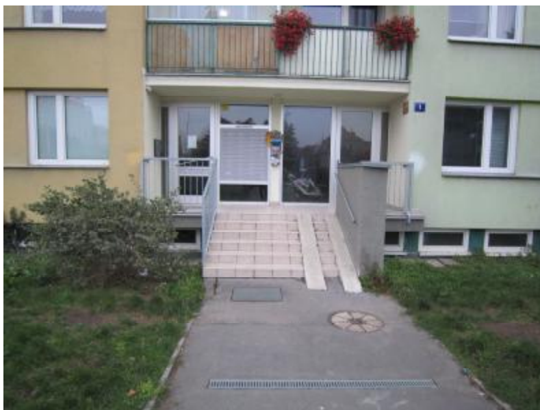
FOTO 1 : Celkový pohled na vstup z ulice Cafourkovy 520/1.
